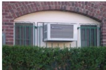
La abertura abovedada original ha sido tapada con la instalación de un acondicionador de aire y con ventanas más pequeñas.
