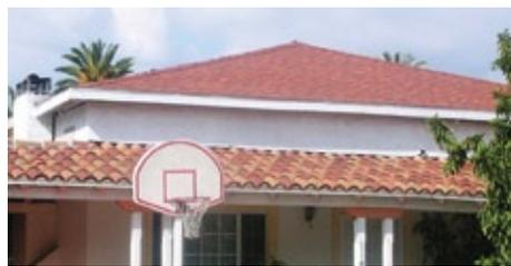
Parte del techo original de las tejas de barro ha sido cambiado a tejas de asfalto.
