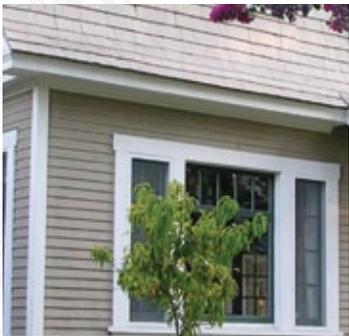
Algunos edificios como éste tienen dos tipos de revestimiento, tablas solapadas en la parte inferior y tejas en la parte superior.
